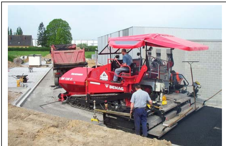
La Svedala Demag DF 135 C trabajando en una obra pequeña
