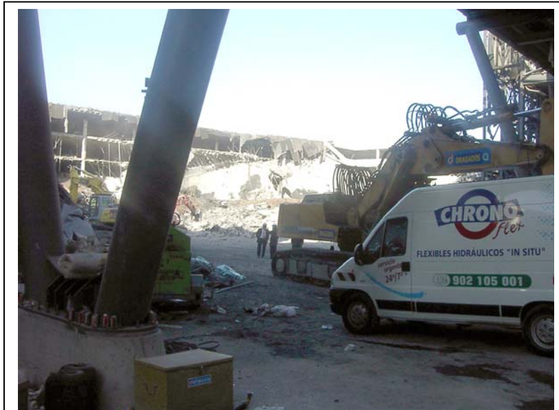
Maquinaria y servicios de acuda se afanan por agilizar las tareas de desescombro para comenzar cuanto antes la reconstrucción del aparcamiento
